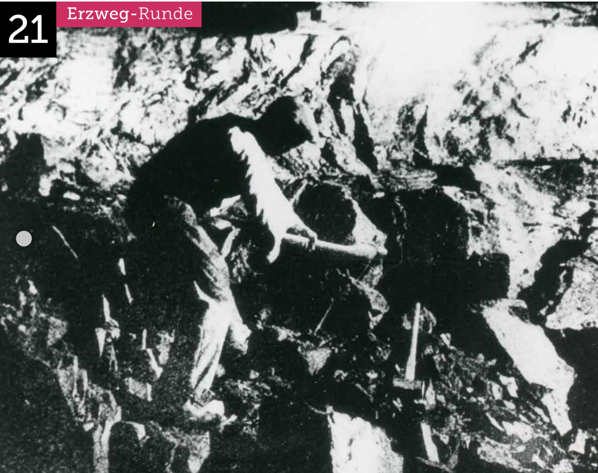
Wie löst man das Eisenerz aus dem unterirdischen Gebirgsgestein? Traditionell schlugen die Bergleute mit Schlägel und Eisen große Stücke aus den Stollenwänden und zerkleinerten sie auf tragbare Größen. Diese mühsame Arbeit erleichterte ab 1753 die Sprengtechnik. Dabei wurden per Hand Sprenglöcher in das Erz gebohrt.
