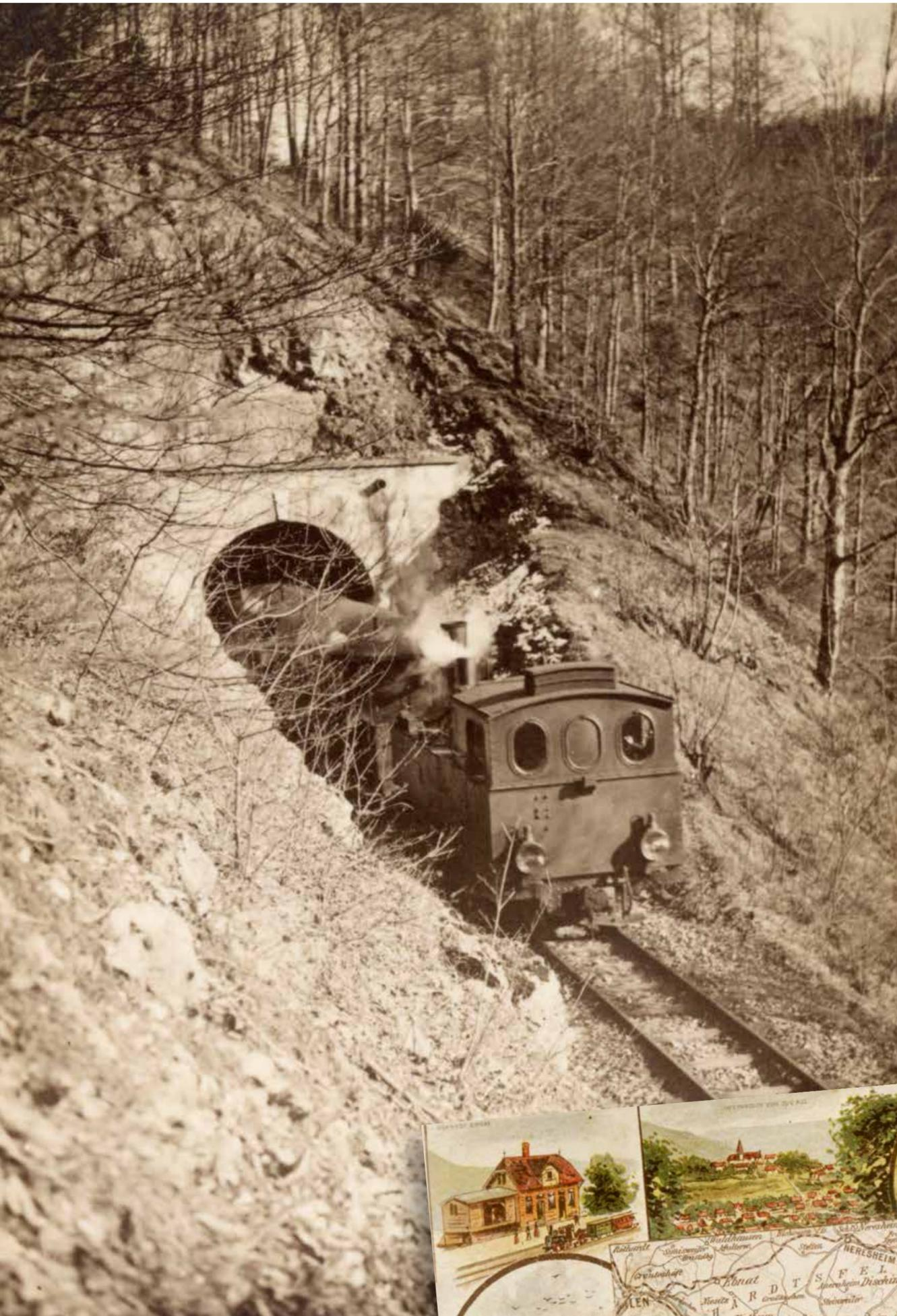
Zirka 130 Meter weiter östlich von Ihnen befindet sich der Höllhau-Tunnel, mit dessen Hilfe die »Schättere«-Schmalspurbahn von 1901 bis 1972 einen schmalen Bergkamm durchquerte. Bei der Grabung des 96 Meter langen Tunnels stießen die Bauarbeiter einst auf eine Naturhöhle, die aufwändig zugemauert worden ist. Nach Einstellung des Eisenbahnbetriebs siedelten sich zahlreiche Fledermäuse in Tunnel und Höhle an. Zu deren Schutz ist die Durchquerung des Tunnels heute verboten (©Stadtarchiv Aalen).
